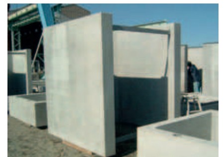
Transporte del pozo de ascensor a la obra en varias secciones
