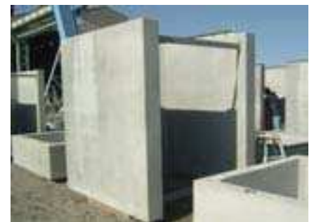
Prefabrykowany szyb windowy jest transportowany na plac budowy w częściach.
