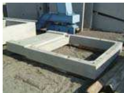
Prefabrykowany szyb windowy jest transportowany na plac budowy w częściach.
