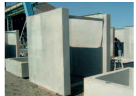
Transport vers le chantier en plusieurs étapes d'une cage d'escalier en éléments préfabriqués en béton
