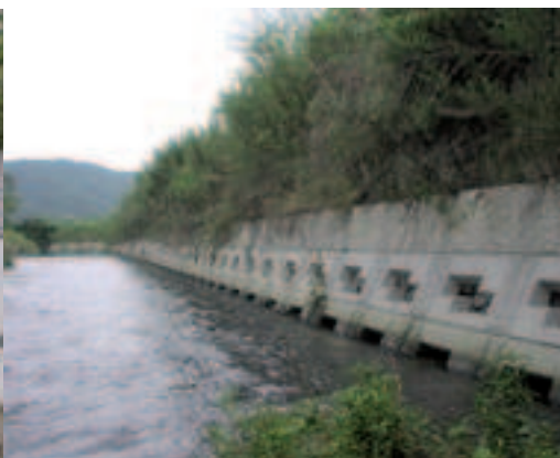
2a, b, c: Przykłady ekologicznych bloczków do umacniania brzegów rzek.
