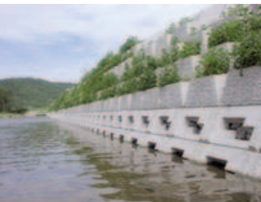
2a, b, c: Przykłady ekologicznych bloczków do umacniania brzegów rzek.
