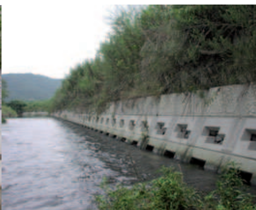
Fig. 2a, b, c: Esempi di blocchi che migliorano sia la funzione di rinforzo sia l'ecocompatibilità.
