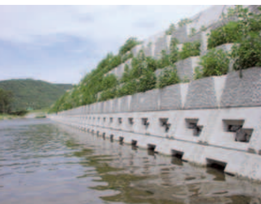
Fig. 2a, b, c: Esempi di blocchi che migliorano sia la funzione di rinforzo sia l'ecocompatibilità.
