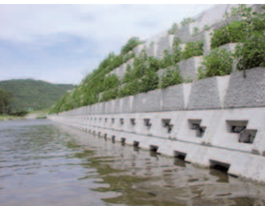
Fig. 2a, b, c: Exemples de blocs qui assurent une fonction de stabilisation et contribuent à une réduction de l'impact sur l'environnement.
