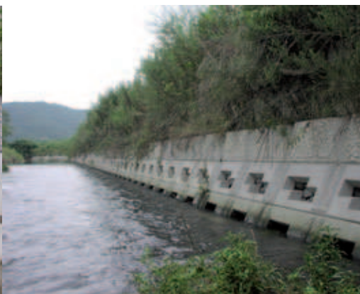
Fig. 2a, b, c: Exemples de blocs qui assurent une fonction de stabilisation et contribuent à une réduction de l'impact sur l'environnement.
