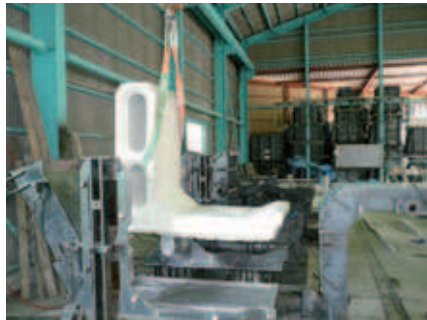
Planta de producción con encofrados de Toyotaforms Fig. 9 Proceso de desencofrado
