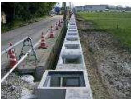
Fig. 3a: Canteiro de obras
