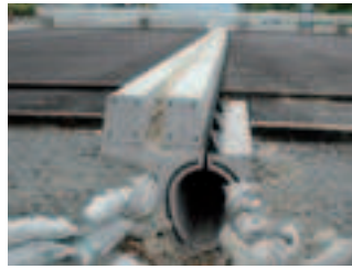
4b: Przykład odwodnienia przy budowie drogi.
