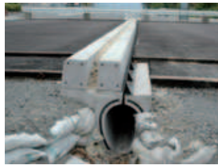
Fig. 4b: Esempio durante la costruzione di una strada
