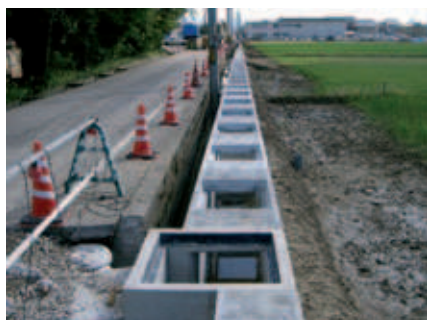
Fig. 3a: Drainage mis en place sur un chantier
