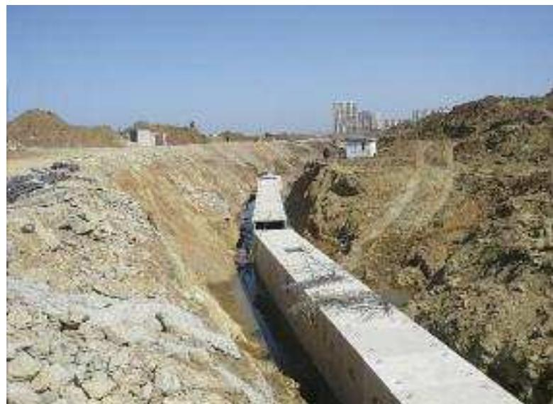
Fig. 8: Aduelas no local da obra, fabricadas pela Toyotaforms
