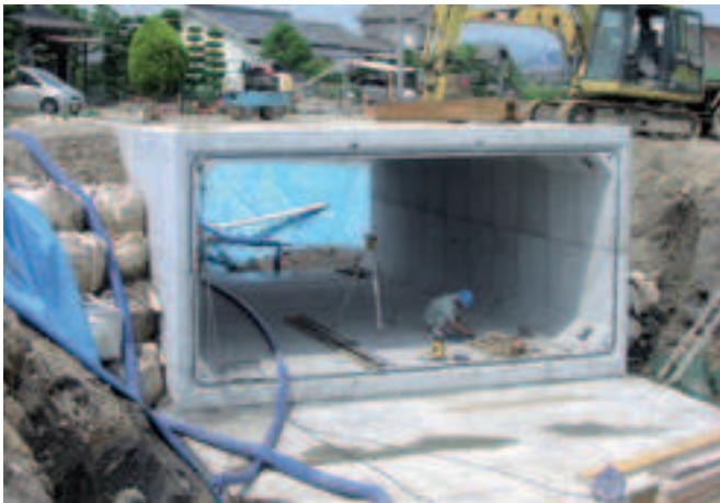
1, 2: Przepusty skrzynkowe na placu budowy.
