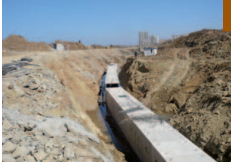
8: Przepusty skrzynkowe na placu budowy, wyprodukowane za pomocą form firmy Toyota.
