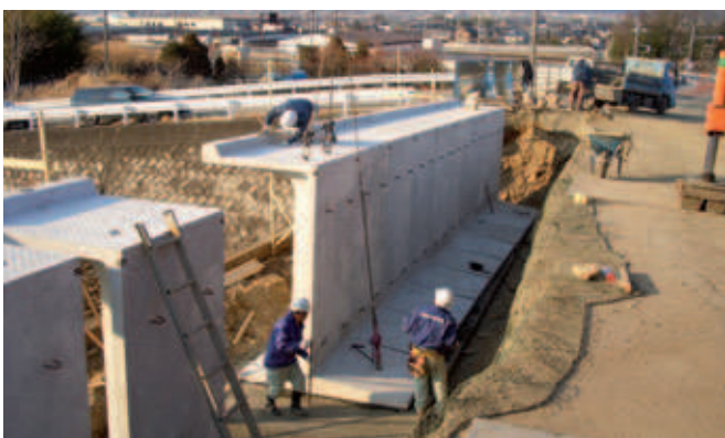
Fig. 3 y Fig. 4: El sistema “Road L” en la obra y una carretera ampliada con él
