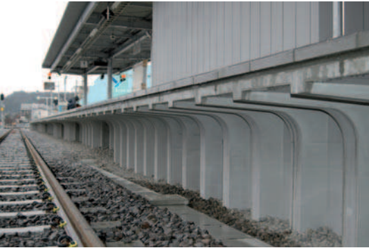
5: Elementy Road L są w Japonii często wykorzystywane do budowy peronów stacji kolejowych.
