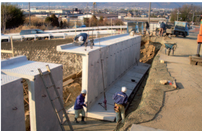
3, 4: Elementy „Road L” na placu budowy oraz poszerzona jezdnia.
