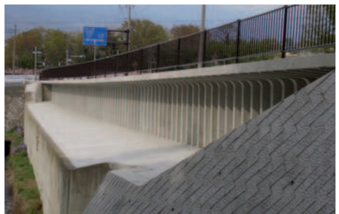
Fig. 3, Fig. 4: Des éléments 'Road L' sur le chantier; Voie de circulation élargie grâce à 'Road L'
