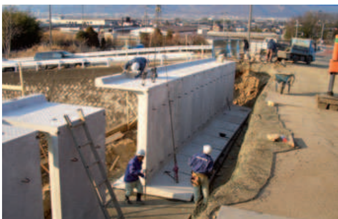
Fig. 3, Fig. 4: Des éléments 'Road L' sur le chantier; Voie de circulation élargie grâce à 'Road L'
