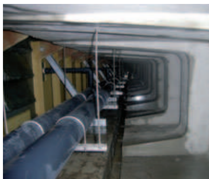
Fig. 6: Construction d'une piscine
