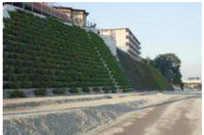
System ekologicznych murów oporowych składa się z betonowych elementów wykorzystywanych do umacniania skarp drogowych...
