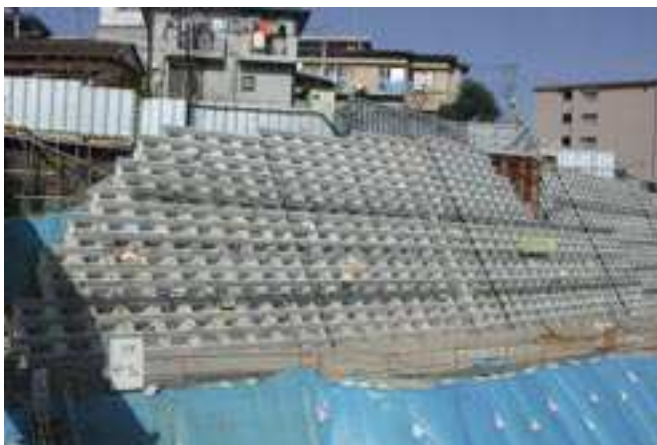
Ekologiczny mur oporowy podczas budowy.
