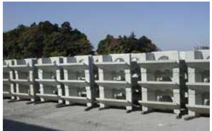
Elementy ekologicznych murów oporowych na placu składowym.
