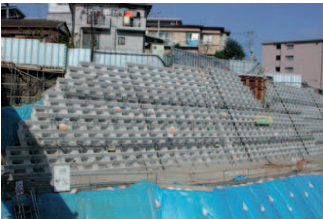
Il "muro di contenimento verde" in fase di costruzione
