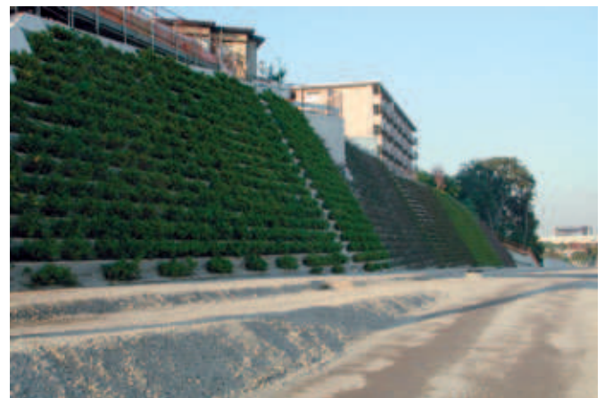
Il muro di contenimento con rinverdimento è un blocco cementizio
