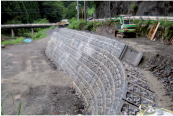
Fig. 2a, 2b: Bloques de hormigón tipo cajón
