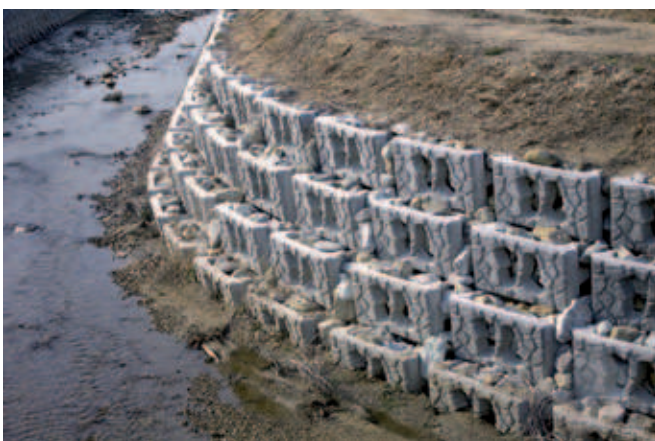
Ill. 1a, 1b: Éléments en béton pour la consolidation des berges
