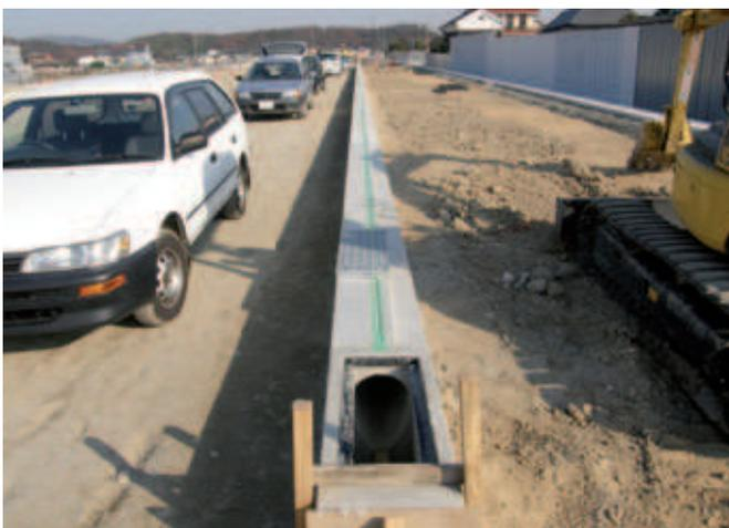
Fig. 3: Colocación de elementos de drenaje
