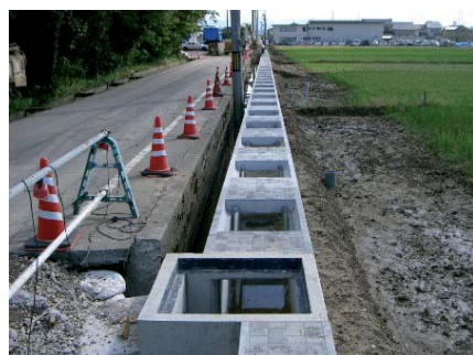
Fig. 3a: Construction Site
