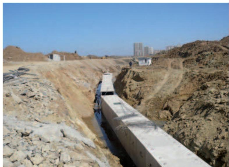
Fig. 8: Dalots sur un chantier, réalisés dans des moules de Toyotaforms
